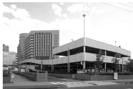
附属病院立体駐車場 （竣工：H23.9.30 建築費：173百万円）
