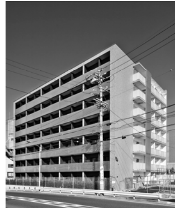
インターナショナルレジデンスサウス （竣工：H24.2.27 建築費：408百万円）
