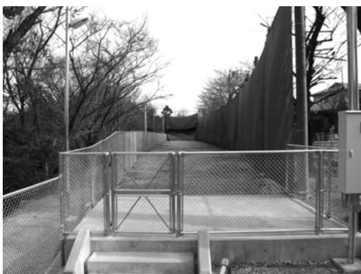
アーチェリー練習場改修 (竣工：H24.3.1 建築費：15百万円)
