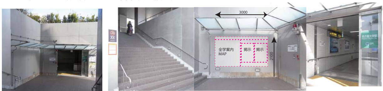
図 6-8 I B 館側地下鉄出入口付近 現状
