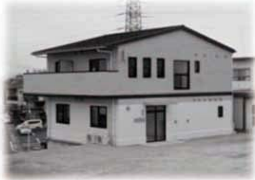
ポート艇庫 (竣工：H23.3.24 建築費：41百万円)
