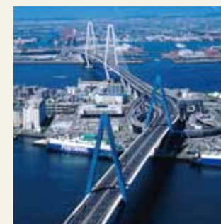
名古屋港跨海大桥
