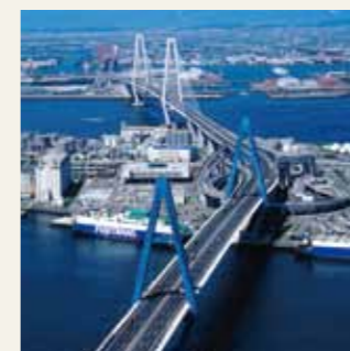
名古屋港跨海大桥
