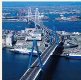
名古屋港跨海大桥
