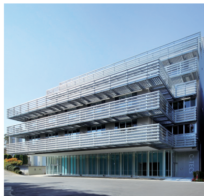
CIRFE能源转换电子研究馆 (C-TECs) 外观
