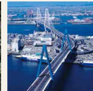
名古屋港跨海大桥
