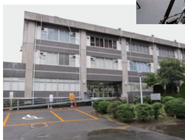
工学部7号館B棟
