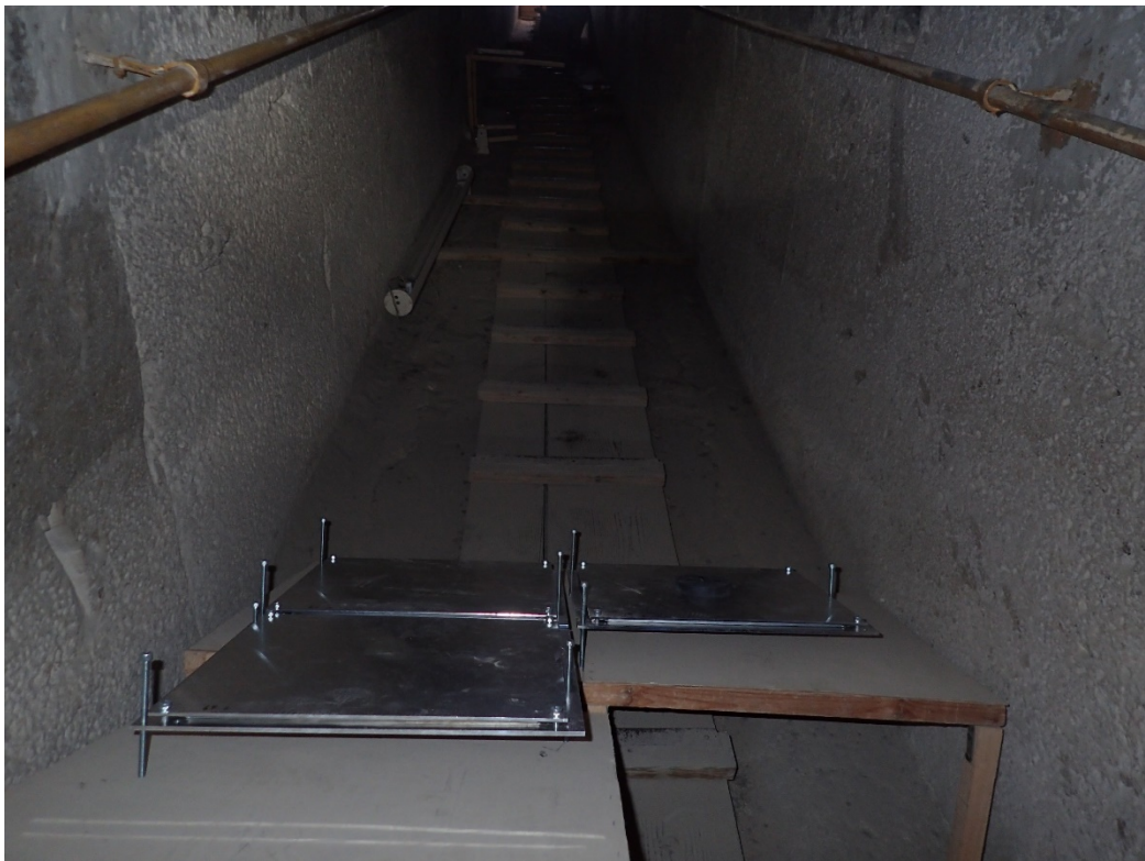
図 7. 下降通路に設置した 3 つの原子核乾板検出器の様子
