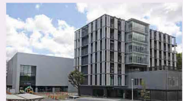
エネルギー変換エレクトロニクス実験施設(C-TEFs)と研究所共同館Ⅱ
