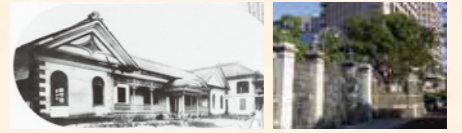
天王崎の愛知医学校校舎 愛知医学専門学校遺構 名古屋大学の創基にあたる、1871(明治4)年に設置された医学校・病院は、1877(明治10)年に天王崎(現在の名古屋市中区栄1丁目)のおよそ18,800㎡の敷地に移転した。 堀川河畔の街路に面した表門を入り、植え込みに囲まれた爪先あがりの道を右へ登ると病院が、左へ向かうと医学校があった。和洋折衷の建物は、出入り口や窓枠にアーチを取り入れられ、白漆喰にガラス窓の二階建て建築で、堀川河畔の高台にその偉観を誇った。当時「河の病院」と呼ばれ、人々に親しまれた。 1914(大正3)年に現在の鶴舞キャンパスへ移転し、その跡に建てられた愛知県立医学専門学校の正門等が現存しており、国の登録有形文化財として2007(平成19)年に登録された。
