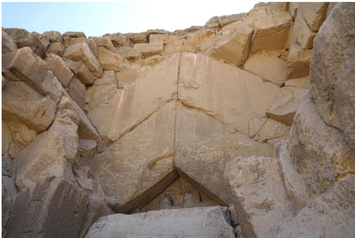
図 3:シェブロン(良質な石灰岩で構成された切妻構造と呼ばれる様式)
