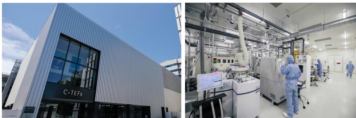
図4. 名古屋大学未来材料・システム研究所のエネルギー変換エレクトロニクス実験施設(C-TEFs)。本施設は、GaN 研究における結晶成長・デバイスプロセス・評価を同一スペースで行える約 1,000 m 2 の大空間クリーンルームを有しており、名古屋大学と企業・研究機関の連携を強化する場となっている。
